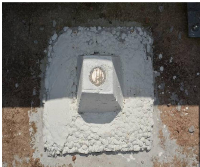
Figura 53 – RN instalado no maciço do barramento.
